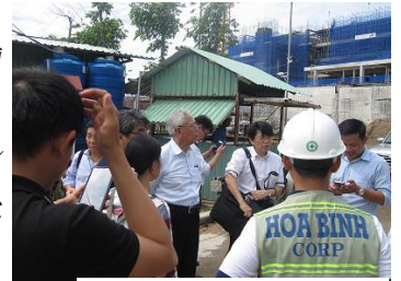
フーコック工事現場
